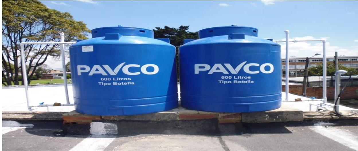
En enero de 2015 se demuelen 6 tanques de fibrocemento en las casas perimetrales de la Quinta de Mutis y 4 en el Claustro, los cuales son reemplazados por 10 tanques de plástico PVC tipo botella que mejoraran las condiciones higiénico sanitarias de almacenamiento de agua potable, facilitaran los procesos de limpieza y desinfección que se realizan semestralmente y eliminaran por completo posibles trazas de PCB existentes en los tanques de la universidad.
